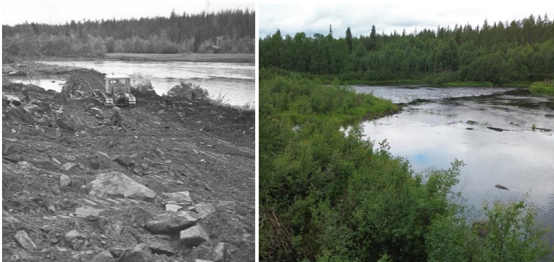
Kuva 72. Juurakkokosken puskutraktoriperkuuta 1950-luvulla ja kuva samasta kohta noin 70 vuotta myöhemmin 2024.
